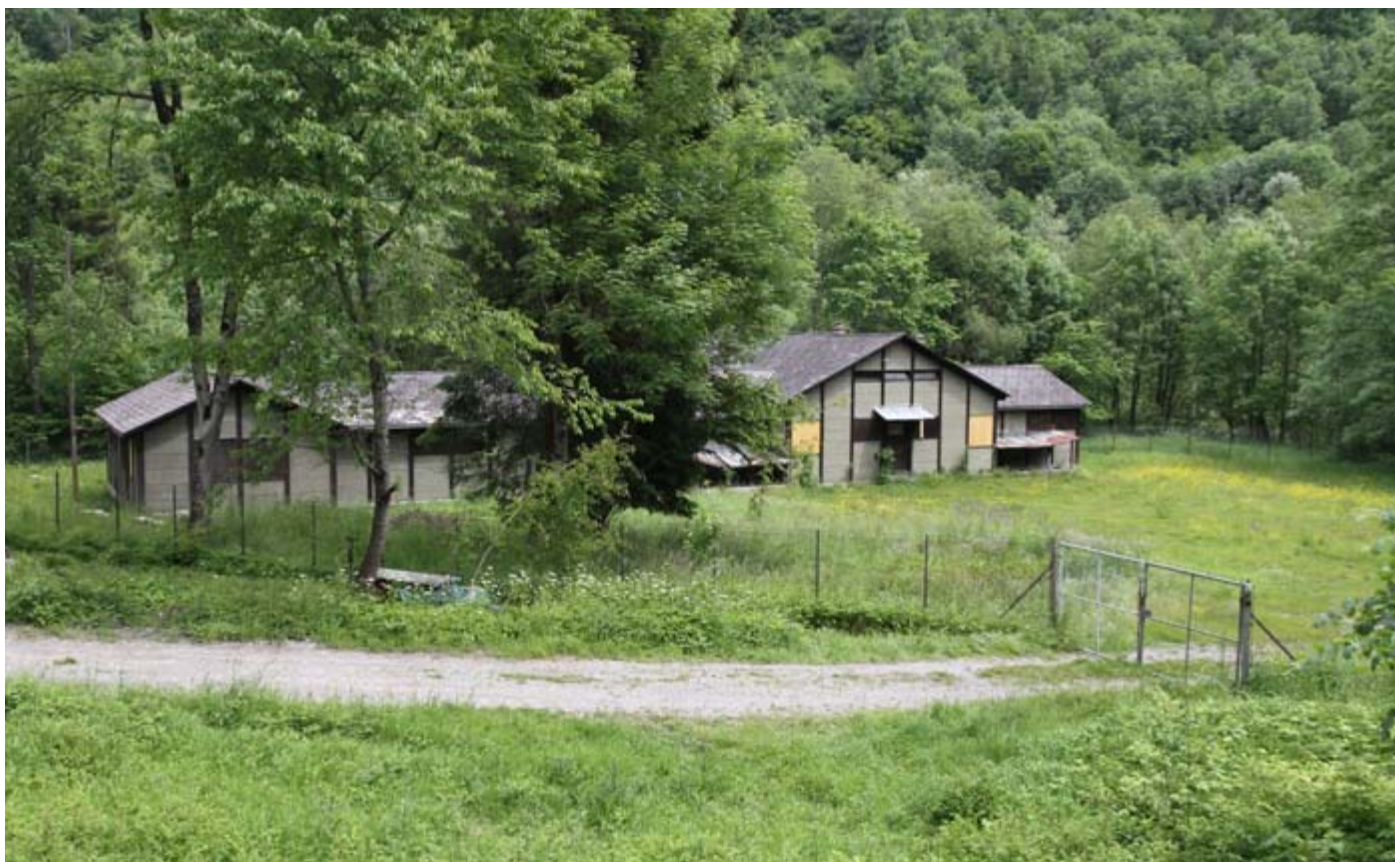
Abb. 4: Altes Militärspital Ilanz nach Fertigstellung der Renovationsarbeiten. Foto: Erich Mühlethaler
